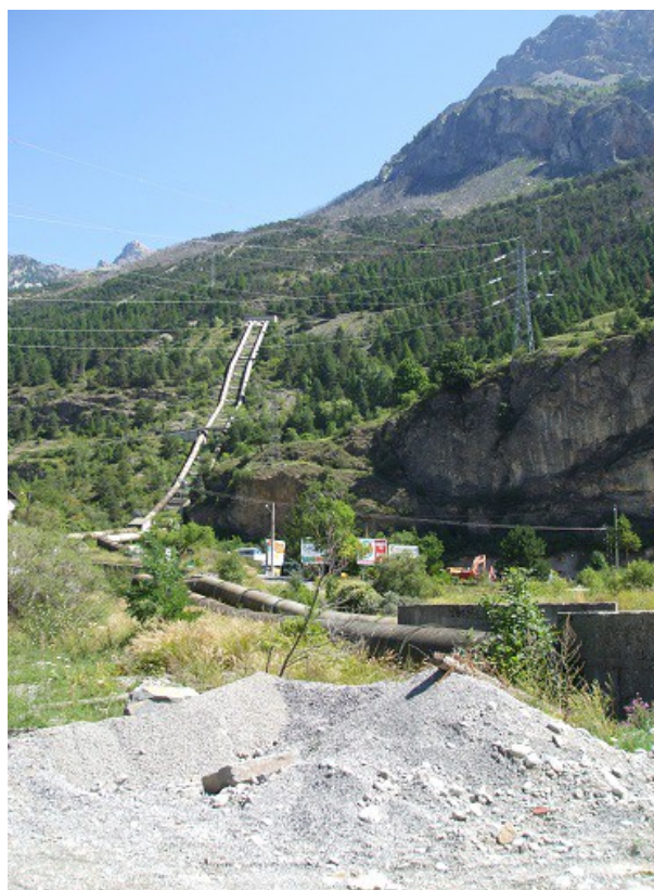
Photo 8 – arrivée des 2 conduites avant l'usine, avant franchissement de la Durance; on distingue les dernières chutes de hauteur 174 m (photo: Frédéric Élie, 18/08/2008)
