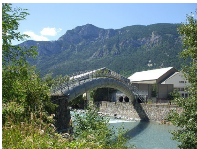
Photo 9 – ultime franchissement de la Durance par un petit « siphon » avant entrée dans l'usine hydro-électrique de L'Argentière (photo: Frédéric Élie, 18/08/2008)
