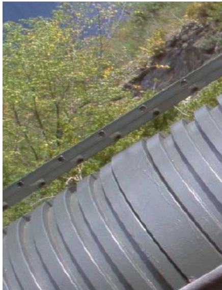
Photo 1 – exemple de virole frettée par cerces
