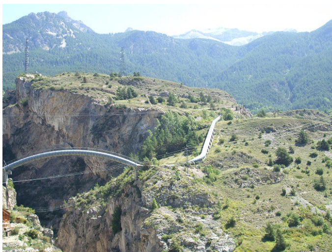
Photo 7 – siphon de la conduite forcée de L'Argentière-La Bessée franchissant la Durance à quelques kilomètres au sud de Briançon (photo: Frédéric Élie, 18/08/2008)
