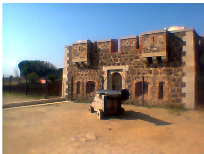
Batterie du cap Nègre, au bout du parc de la Méditerranée: le fortin abrite un petit musée
